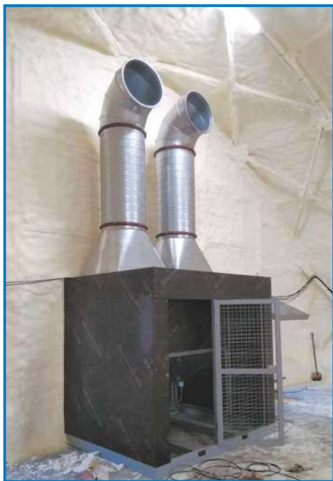
Типичный пример модуля общеобменной (пространственной) вентиляции. Управляющие блоки VENTOGLAS вынесены за пределы камеры хранения (для контейнерного хранения)
